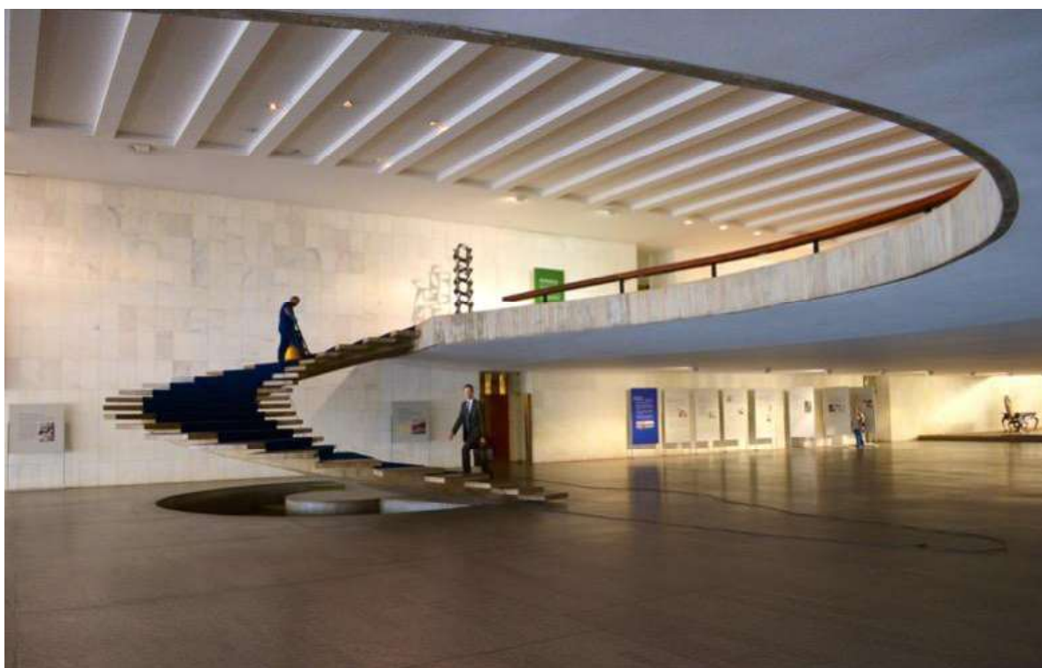
FIGURA 11 Foto da escada a partir do térreo
